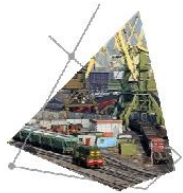
Терминал «Новая Гавань» Ленинградская обл.
